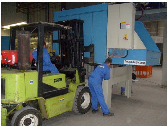
Bild 1: Verlagerung eines Trockners Erwähnenswert sind hierbei die schwierigen örtlichen Verhältnisse in der Wäschereihalle
