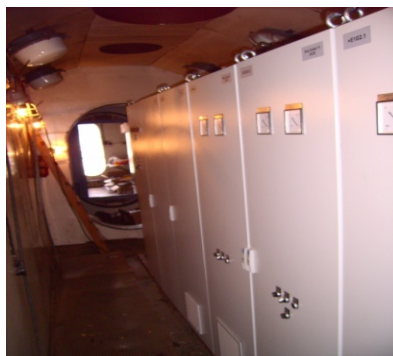
Aufstellung der Schaltschränke nach der Rekonstruktion
