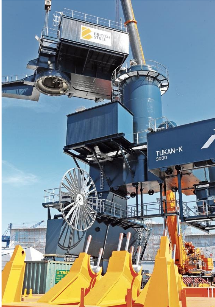
Nach etwa 25 Minuten schwebt das 150-Tonnen-Maschinenhaus auf der richtigen Höhe.
