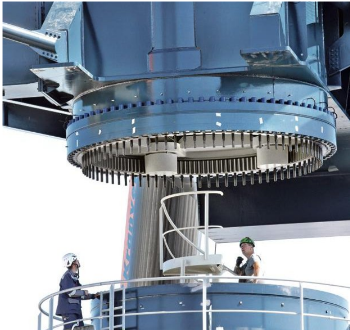
80 Schrauben in 80 Löcher: Für das letzte Stück waren die beiden Kranführer und diese Männer besonders gefordert.
