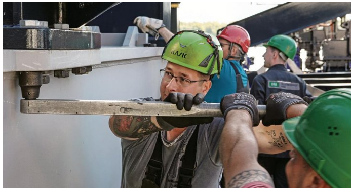
Zunächst haben die Männer alle Schrauben entfernt, die das Maschinenhaus mit den Transporttraversen verbinden.
