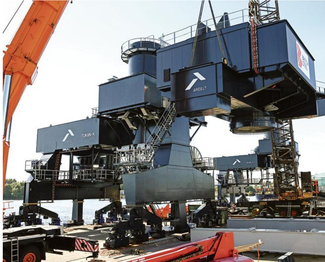
Es geht los: Die Traversen (r., grau) sind gelöst, die Mobilkrane haben die Last langsam und gleichmäßig angehoben. Heute folgt der zweite Kran.
